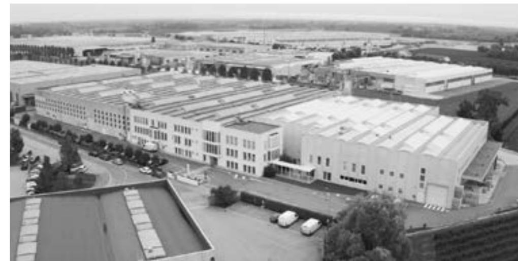
Unit 1: Nicos International Portobuffolè - Sede e sito produttivo di marmoresina 16.400 mq Nicos International Portobuffolè unit - Headquarter and cast marble factory 16.400 sqm
